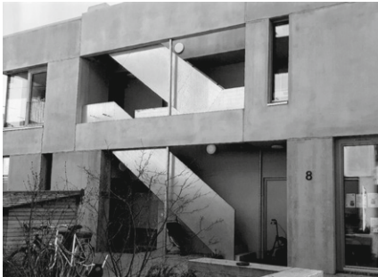
VAMV-Eingang im Brückenhaus Foto: VAMV Tübingen e.V.
